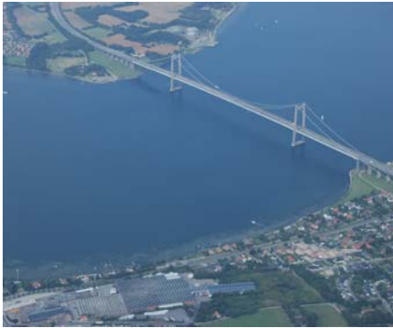
Die Brücke von Middelfart
